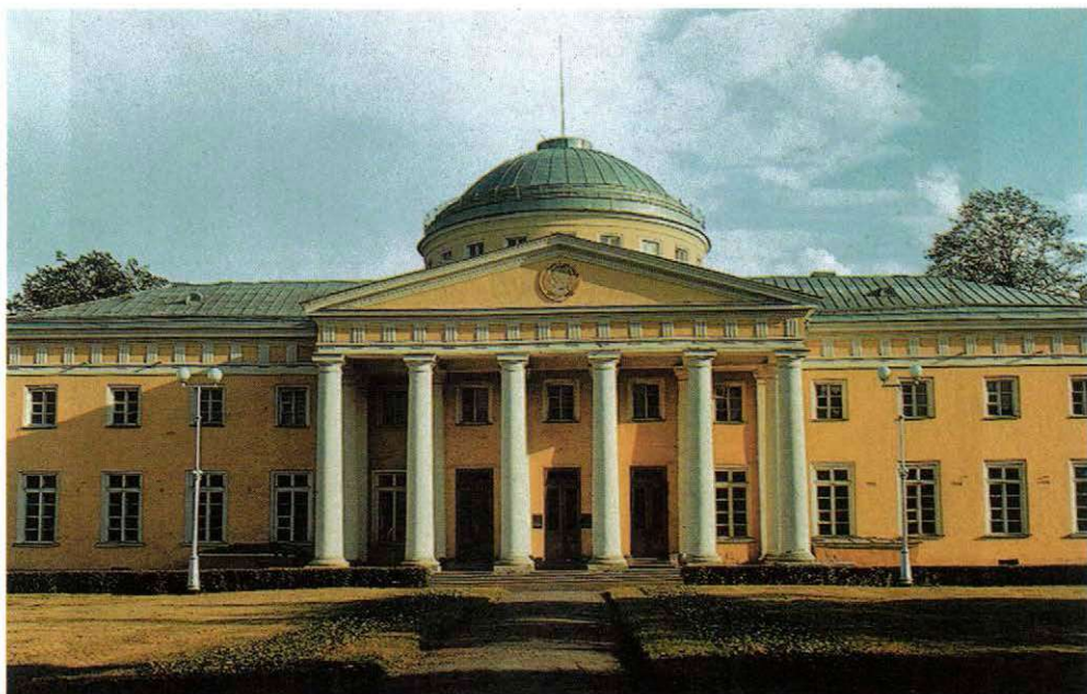
Таврический дворец в Петербурге. Архитектор И. Е. Старов
